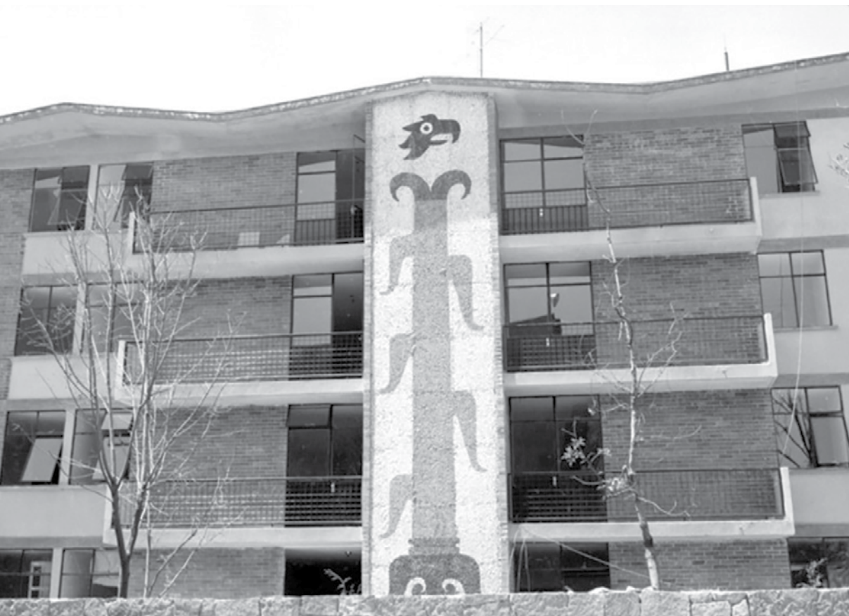
Fotografía 7. Fachada de edificio en la Unidad Independencia, Ciudad de México, 1960.
