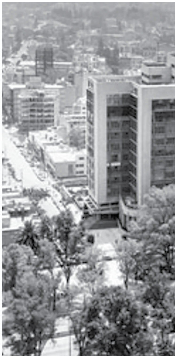
Fotografía 4. Edificio de las oficinas centrales del IMSS, Ciudad de México, Ca. 1960.
